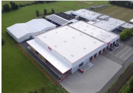
Abbildung 5 – Betriebsgelände Roth Plastic Technology, Wolfgruben
